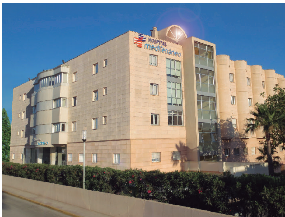
Fachada del Hospital HLA Mediterráneo, en Almería.
