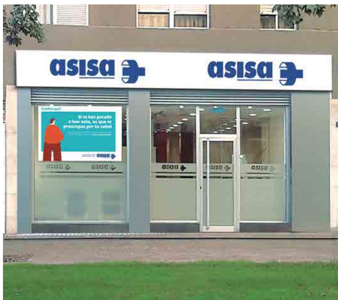
Fachada de la nueva Delegación de ASISA en Tenerife, situada en la calle Rambla de Pulido, 15.
